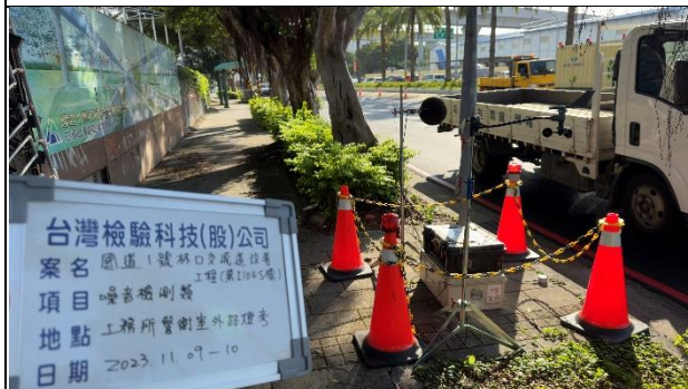
監測項目：環境噪音振動 監測日期：2023.11.09~10 監測地點：工務所警衛室外路燈旁
